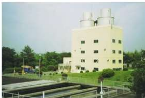
活性炭の投入は長良川河口堰からの取水が始まってから日常的に行われるようになった。
