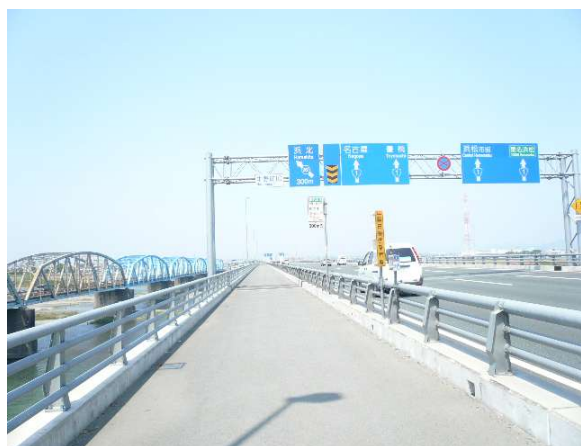
新天竜川橋(左は旧天竜川橋)
